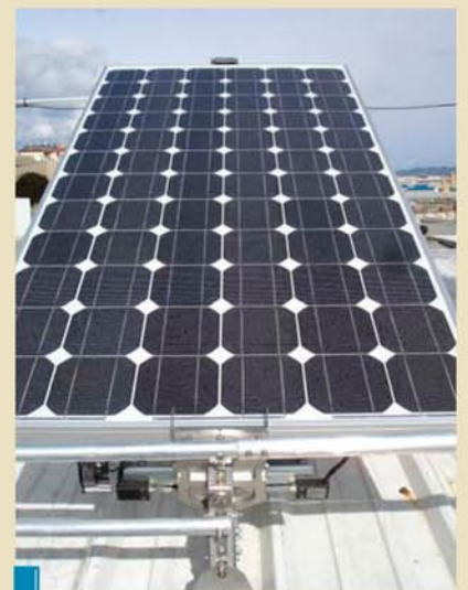
Módulo solar y estructura
