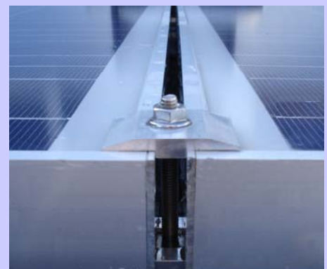
Detalle Fijación Placas
