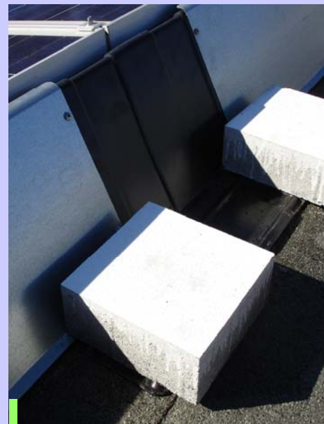
Sujeción mediante Lastre a la Cubierta
